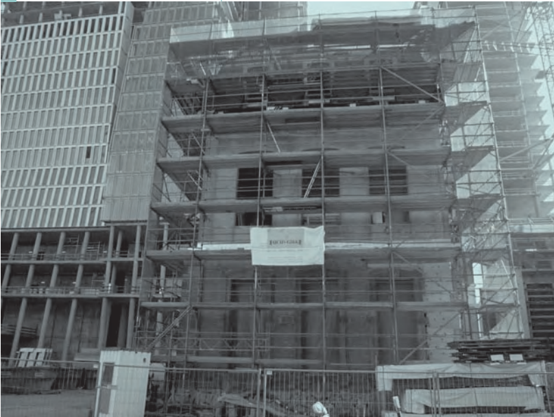
Fig. 6 - Francoforte sul Meno. L'ex palazzo Thurn-und-Taxis in ristrutturazione.
